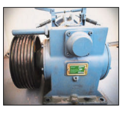
Von der alten Aufzuganlage ist nur der Motor geblieben.
